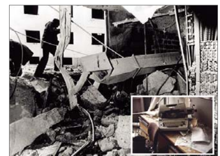
22. Februar 1981: Der Morgen nach dem Anschlag zeigt das Ausmaß der Verwüstungen. Die Bombe riss auf Höhe des heutigen Hörsaal 15 ein 18 Quadratmeter großes Loch in die Mauer. Quelle: Hoover Institution Archives
